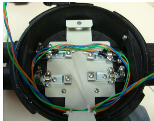
2. Formamos a cada cable un bucle acomodando tubo para sobresalir entre 60-70 cm de tubo del cierre. Bajamos la bandeja de charolas.
