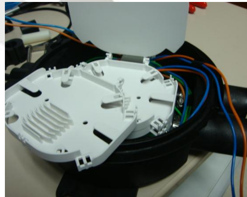
5. Bajamos la bandeja con las charolas de empalme sobresaliendo entre 60-70cm de los tubos que se empalmarán del cierre.
