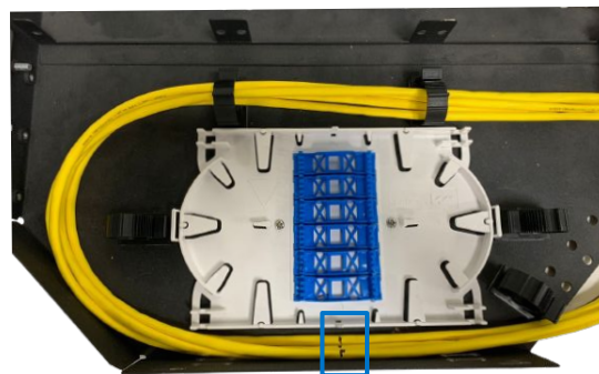
Fig. 13 Marca para corte de tubos holgados
